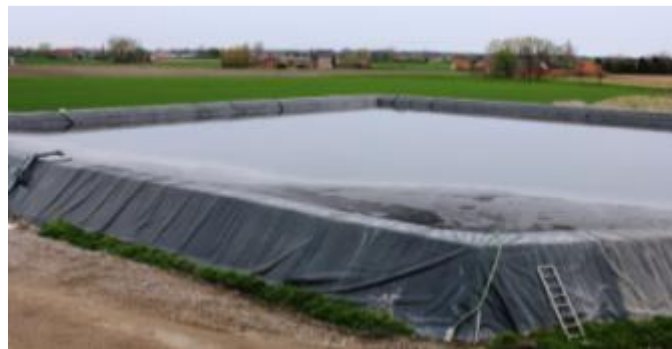
Figuur 4: Effluentbekken met folie over buitentalud.
